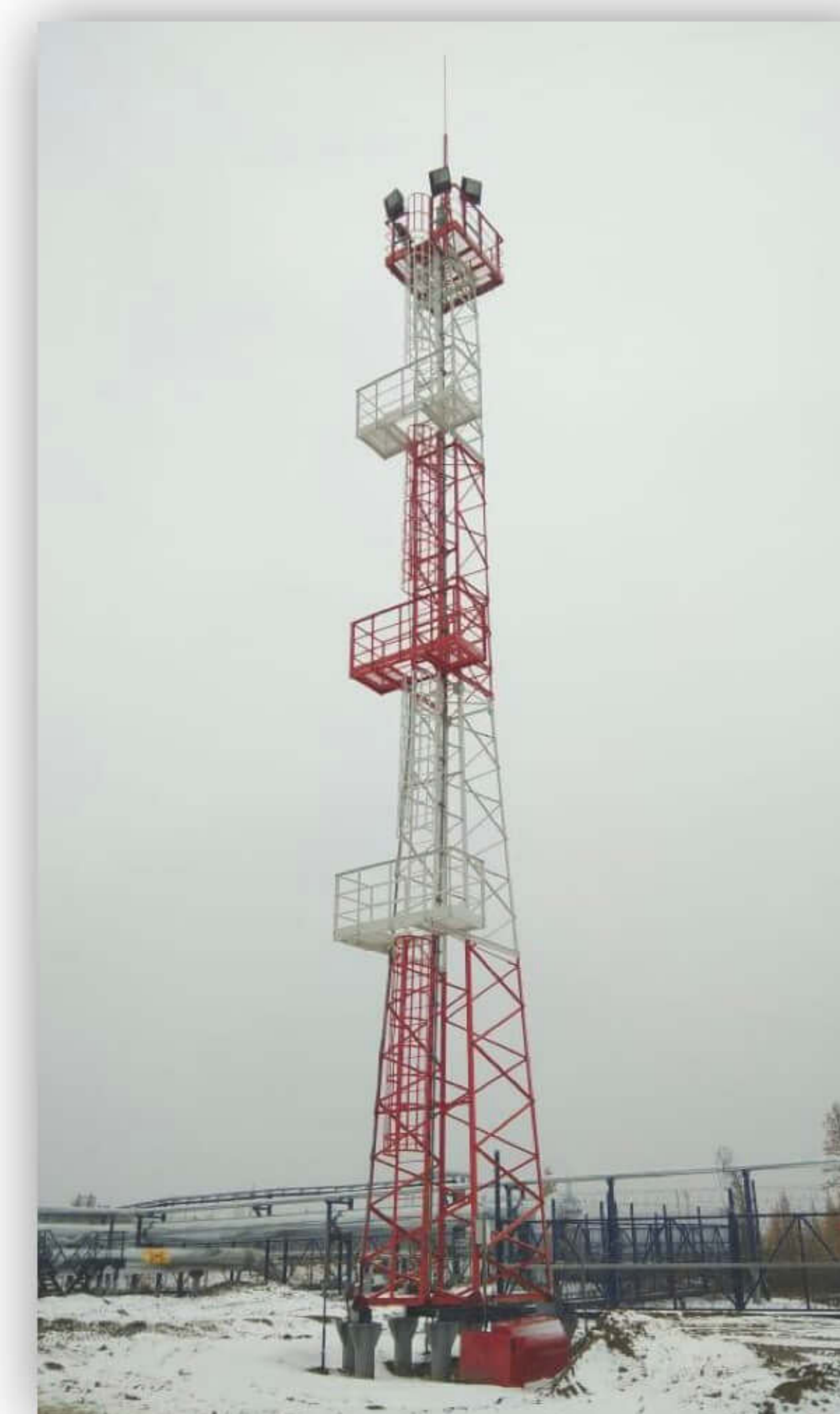
✓ ООО «Газпромнефть-Ямал». Прожекторная мачта ПМС-24 для обустройства кустов газовых скважин Новопортовского нефтегазоконденсатного месторождения.
